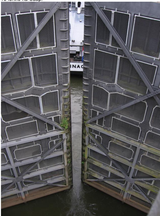
Шлюзът се затваря зад кърмата на кораба. Вратите се управляват с хидравлика. В затворено положение те сключват ъгъл по-малък от 180 градуса, така че хидростатичното налягане упражнява допълнителна сила на затваряне и плътно прилепване на вратите.
