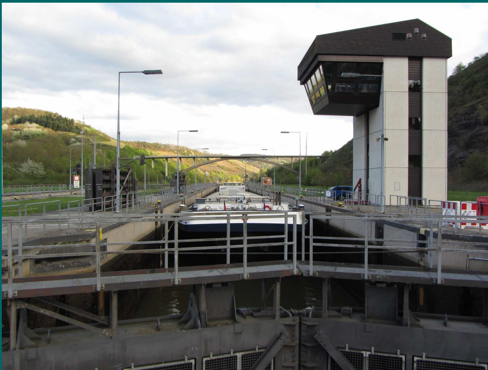
Последният шлюз на Саар при Хам, преди да се влее в Мозел. Корабът изчаква да бъде спуснат на долното ниво.
